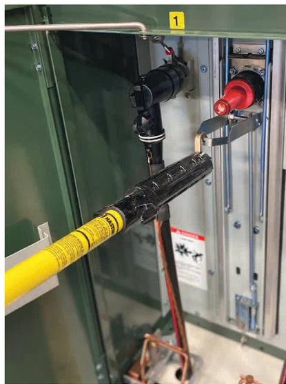
**2** Esto permite que el seguro de interbloqueo mecánico se levante, lo cual hace que el Montaje del TransFuser se desenganche.
