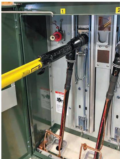
**1** Al mover el codo seccionador de carga hacia un aislador separador o pasante en la base de la conexión se interrumpe la carga del fusible.
