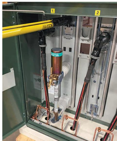
**5** En la posición Abierto, el operario puede tener acceso al fusible, el cual está aislado y desenergizado, para cambiarlo. El panel prohíbe que los contaminantes entren al área de media tensión mientras se cambian los fusibles.
