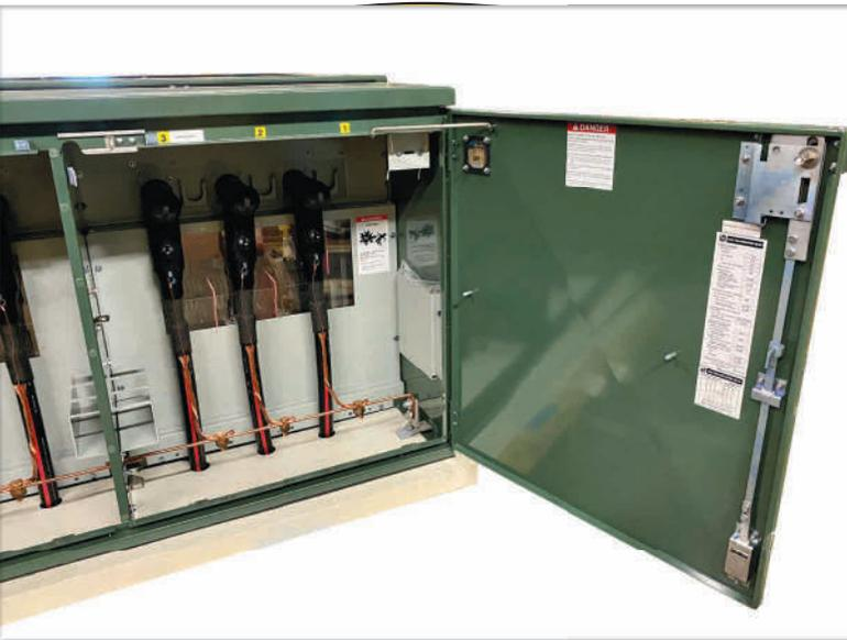
**1** Al cerrar la puerta se libera el Mecanismo de Apertura por Penta-Latch cargado, lo cual engancha la puerta automáticamente en tres puntos y afianza el activador pentagonal.
