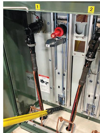
**3** Un ligero tirón que se realiza sin gran esfuerzo desengancha el Montaje TransFuser.
