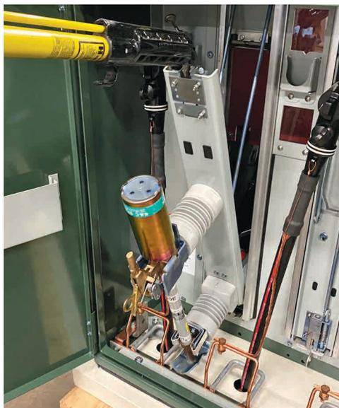
**4** El montaje que cuenta con un balance supremo, gira a la posición de apertura casi por completo y se engancha en su lugar. Dicha acción es rápida y controlada, y evita que el operario quede expuesto a las partes vivas energizadas.
