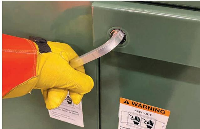
**2** Un solo movimiento del Penta-Latch desengancha el Mecanismo de Apertura por Penta-Latch para abrir dicho mecanismo y al mismo tiempo lo recarga, de esta manera lo prepara para su posterior cierre.
