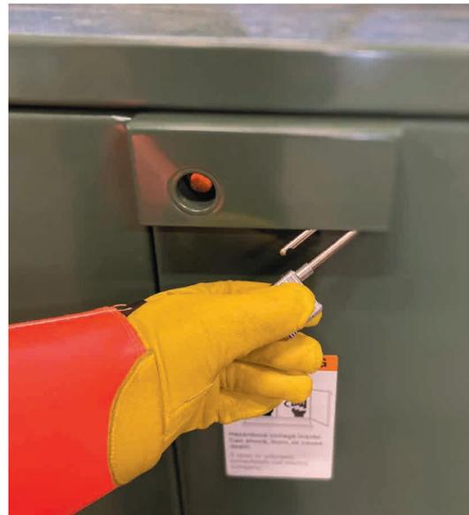
**2** El candado se puede instalar únicamente después de que la puerta quede enganchada y el activador pentagonal quede afianzado, de esta forma se llevan a cabo los dos pasos completos del sistema de seguridad.
